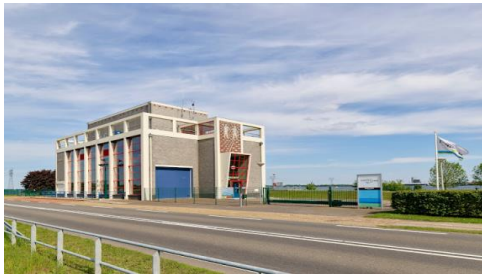
Gemaal Lovink Harderdijk 1 8256 RX Biddinghuizen
